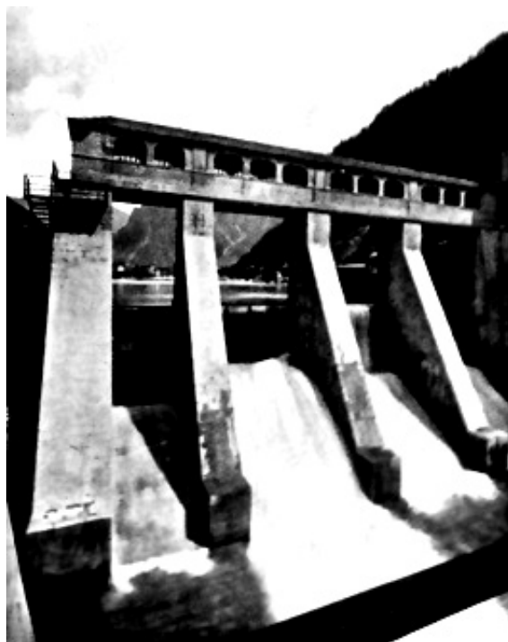
Opere di sbarramento e di presa dal Liro della Centrale di San Francesco a Mera-Adda (1927)
