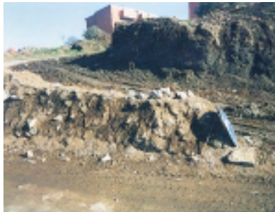
10/1986 - Il tratto di basalto della via verso Frascati; la crepedine; il muro con rivestimento in opera reticolata
