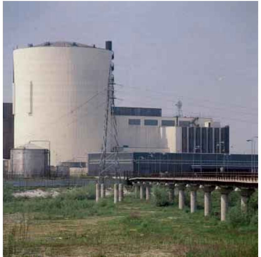
Centrale elettronucleare di Caorso (fermata nel 1986)
