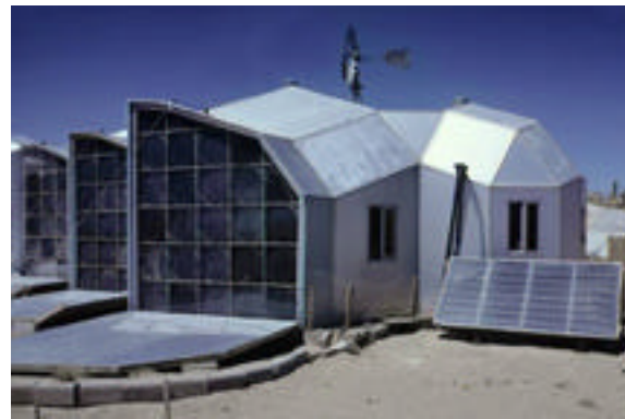
Un esempio di una casa a energia solare. un mulino a vento pompa l'acqua e pannelli solari riscaldano gli ambienti interni.
