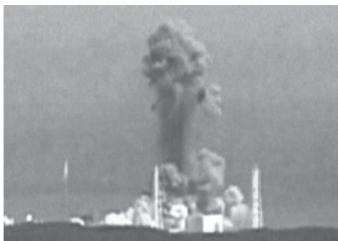
L'esplosione dell'involucro esterno di un reattore della centrale di Fukushima
