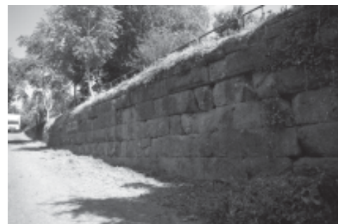
Il primo tratto della Sostruzione ripulito
