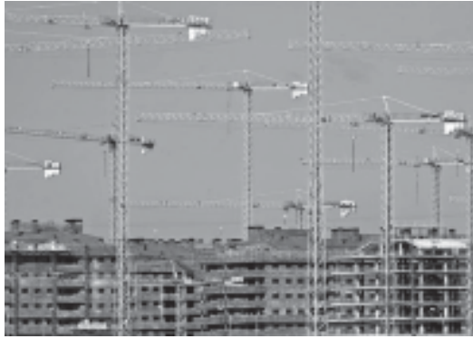
Palazzi in costruzione
