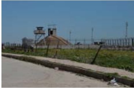
La barriera in costruzione in Turchia
